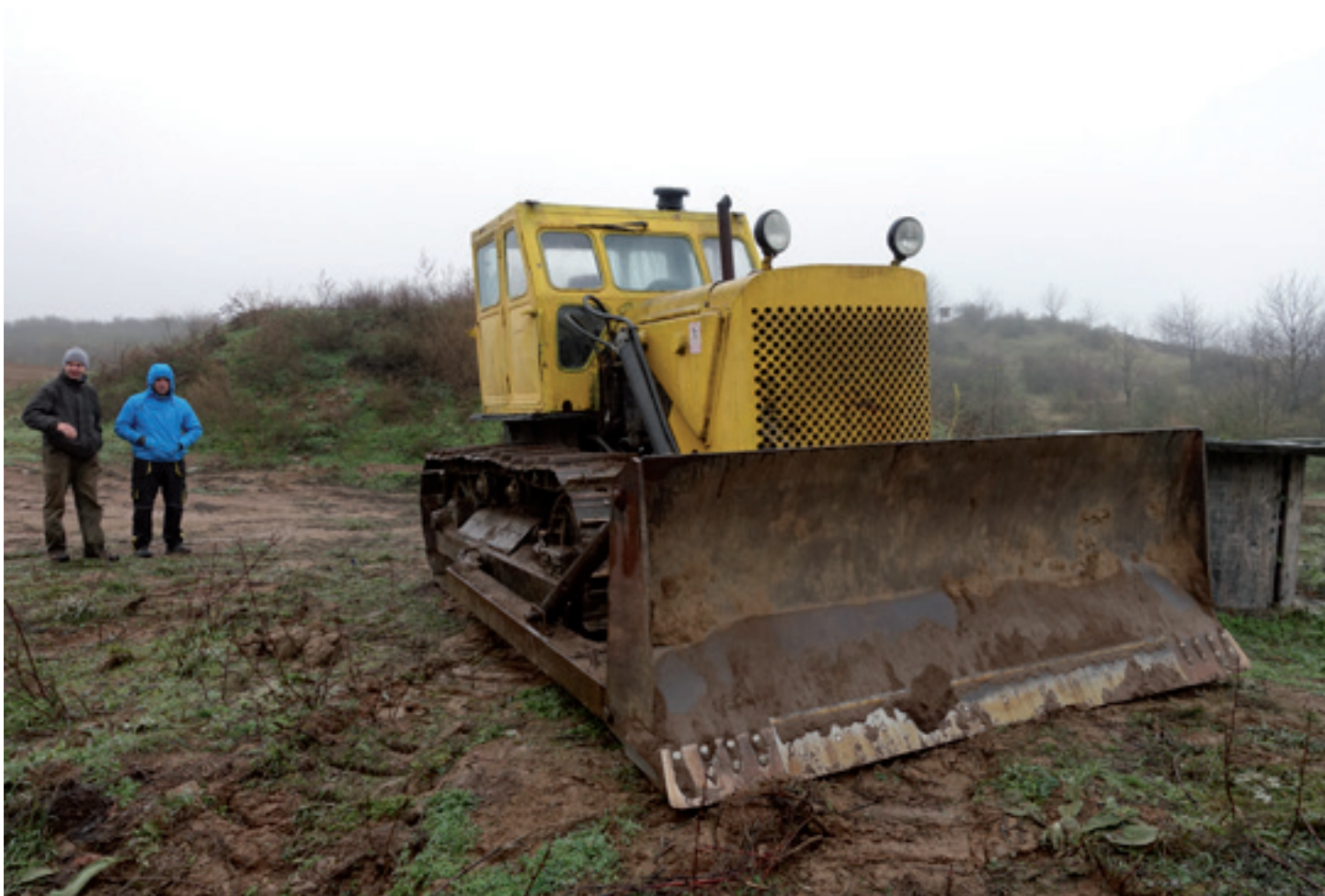
Obr. 7: Stržení drnu za účelem odstranění expanzivní třtiny křovištní na nejvíce zasažených plochách. (Foto: Beleco, 2018)
